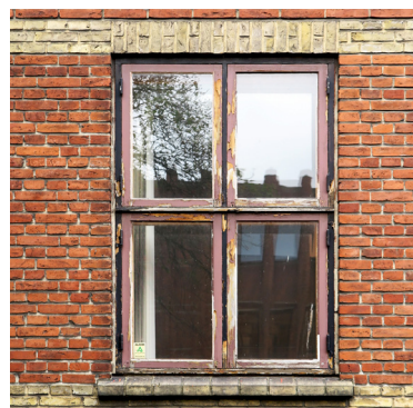
Originalt vindue på østfacaden med eftermonteret forsatsvindue indvendigt.
