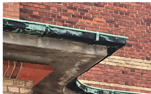
Tage på fremskudte indgangspartier ved sengebygningen i kobber med kobberbeslag.
