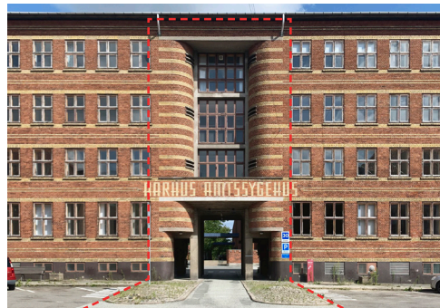
Portbygningens markante modulerede hovedindgang.
