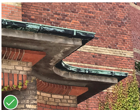
Eksempel på tagrende på markeret indgangsparti (sengebygningen).
