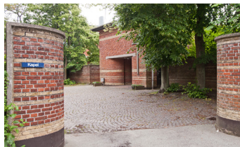
Kapel- og servicebygningen med kapelgård
