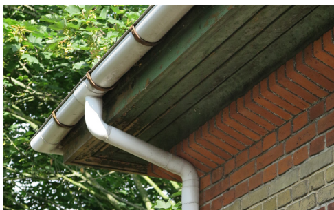
Tagfoden med grønmaledede udhængsbrædder og sternbrædder, som afsluttes af tagrender.
