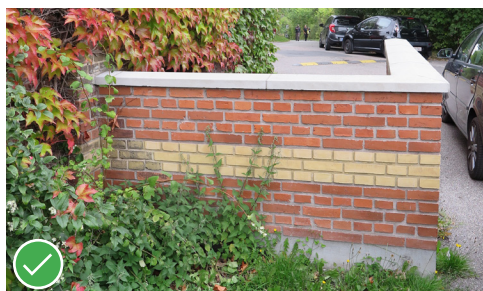
Genopført murværk i stil som oprindelig halvmur. Sokkel er dog ikke malet (sengebygningen).
