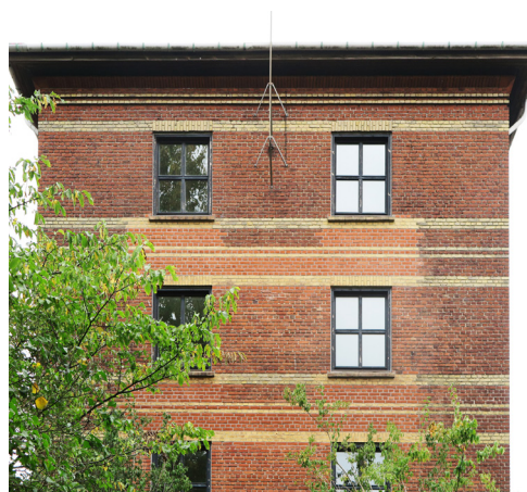
Sydgavlen efter nedrivningen af altaner med nye vinduer.
