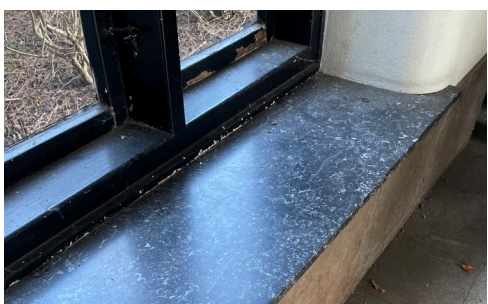
Gulve og vindueskarme i natursten i ankomstrum.
