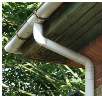
Tagfod med grønmalede stern- og udhængsbrædder.
