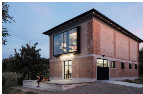
Eksempel på facade med markant vinduesparti.
