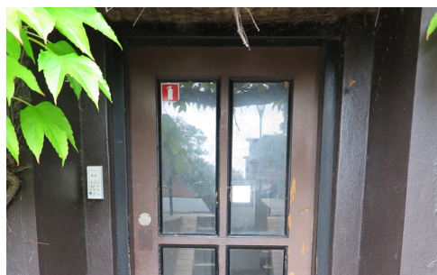
Kælderdør med original, rød-brun dørplade og sorte karme.
