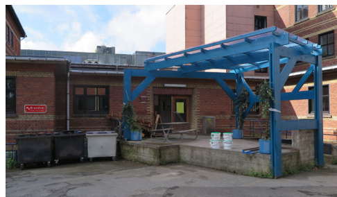
Læsserampe og overdækning på nordsiden af patienthotellet.
