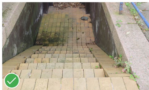
Oprindelig trappenedgang med gule belægningsklinker (portbygningen).
