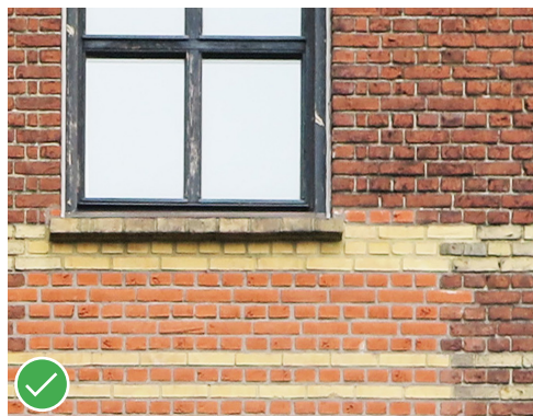
Reparation af murværk omkring vindue (portbygningen).
